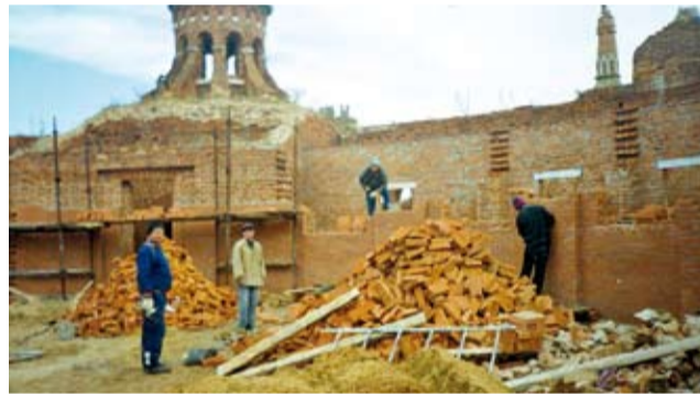
Восстановление скотного двора
