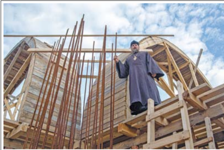
Протоиерей Александр Гривин на строительстве
